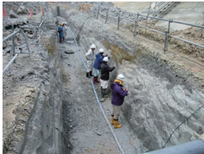
トレンチ（調査用の溝）を掘り、化石層の分布や地層の堆積状況などを調査しました。
