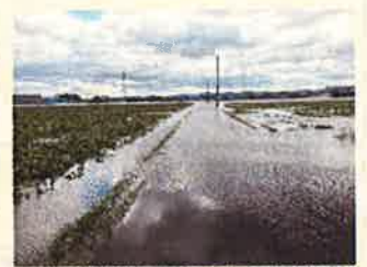
農地の浸水被害（平成29年10月 松阪市）
